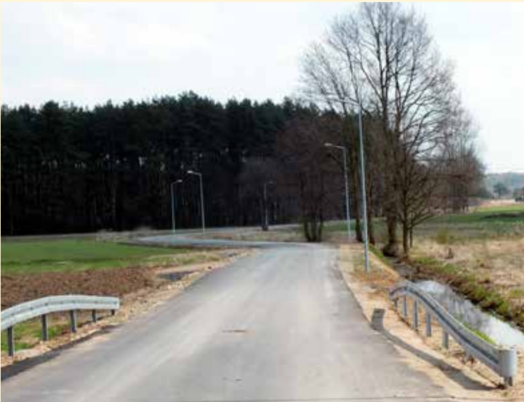
Ulica Pustki po remoncie.
