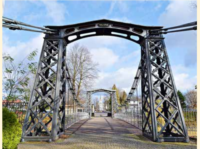
Most po remoncie.
