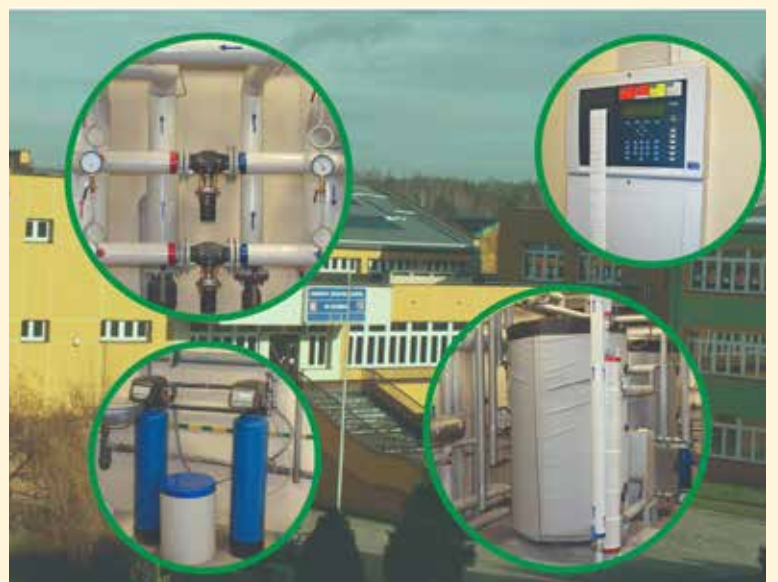
Poprawa efektywności energetycznej Gminnego Zespołu Szkół w Ozimku.
