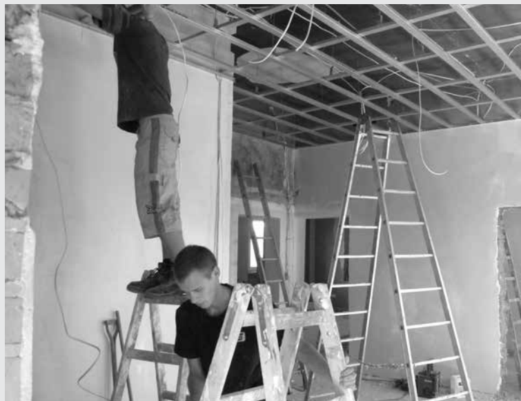
Rozbudowa żłobka samorządowego w Ozimku, dzięki której przybędzie dodatkowych 20 miejsc.
