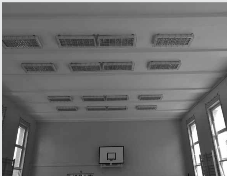
Szkoła Podstawowa nr 1 - sala gimnastyczna po remoncie.
