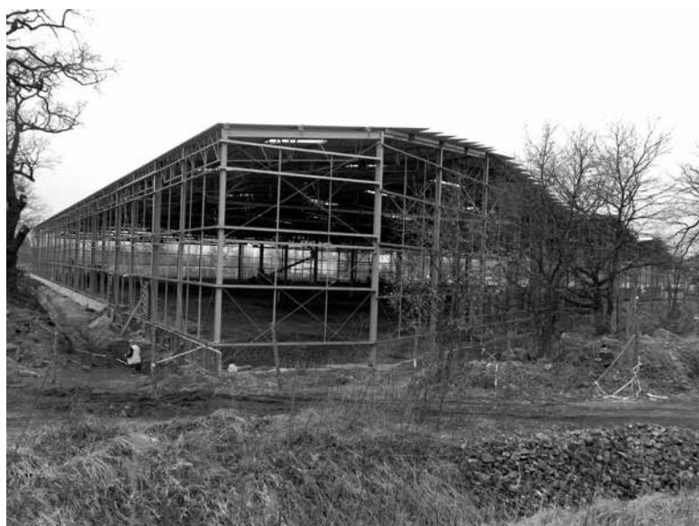
W Jedlicach powstają między innymi nowe magazyny.
