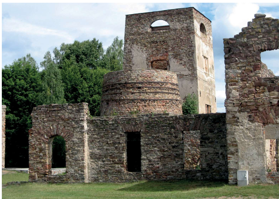
Wielki piec Huty Józef w Samsonowie, którą budował i przez wiele lat zarządzał Christian Schmidt
