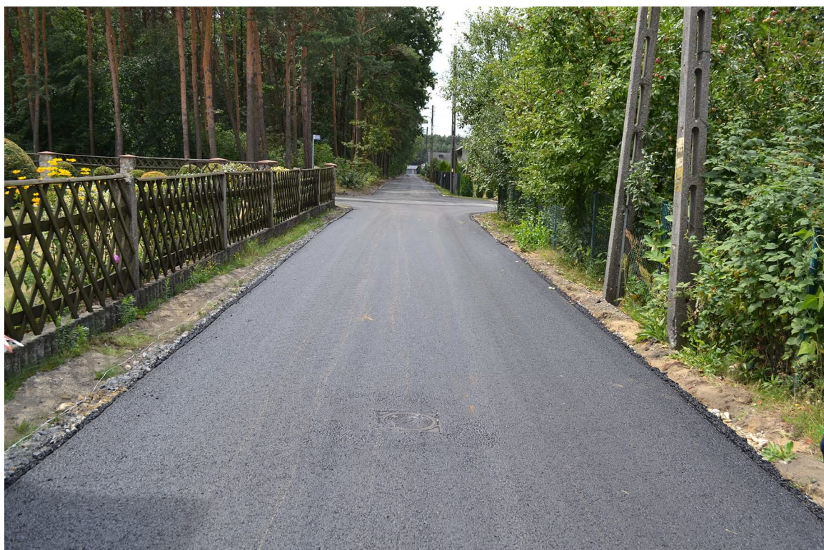
Remont ul. Olimpijskiej w Szczedrzyku
