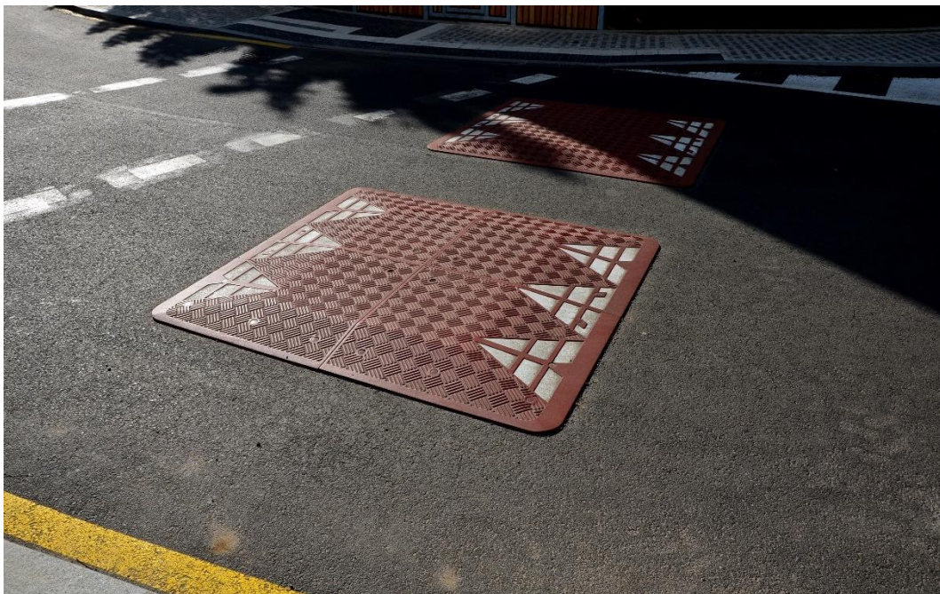
Rysunek 2-18 Próg zwalniający o szerokości zapewniającej płynny ruch autobusów komunikacji miejskiej.
