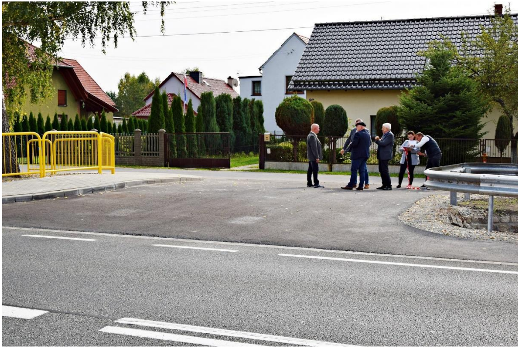
Fot. Przepust na rzece Białka wraz ze zjazdem.
