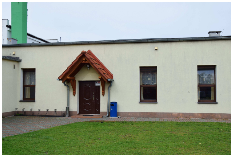
Wymiana okien w świetlicy wiejskiej w Antoniewie
