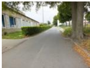
Ul. Słowackiego przed remontem
