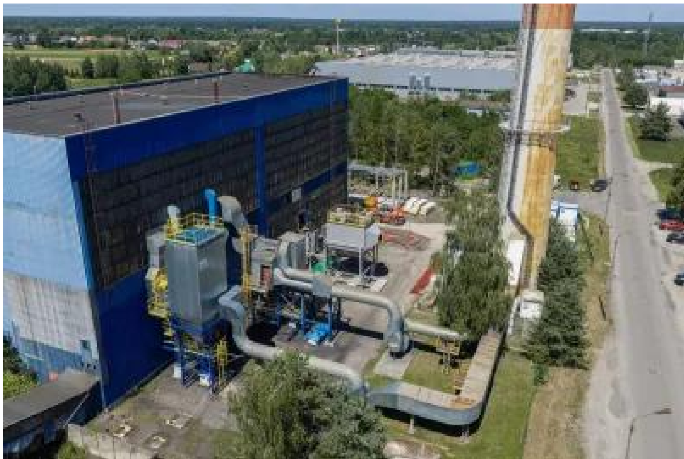
Ciepłownia miejska w Schodni
