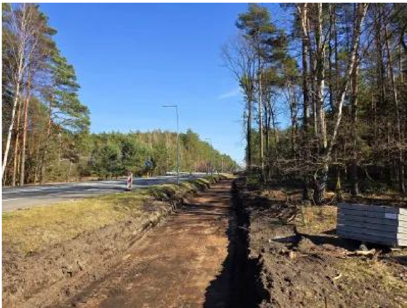
Trwają prace nad budową ścieżki pieszo-rowerowej
