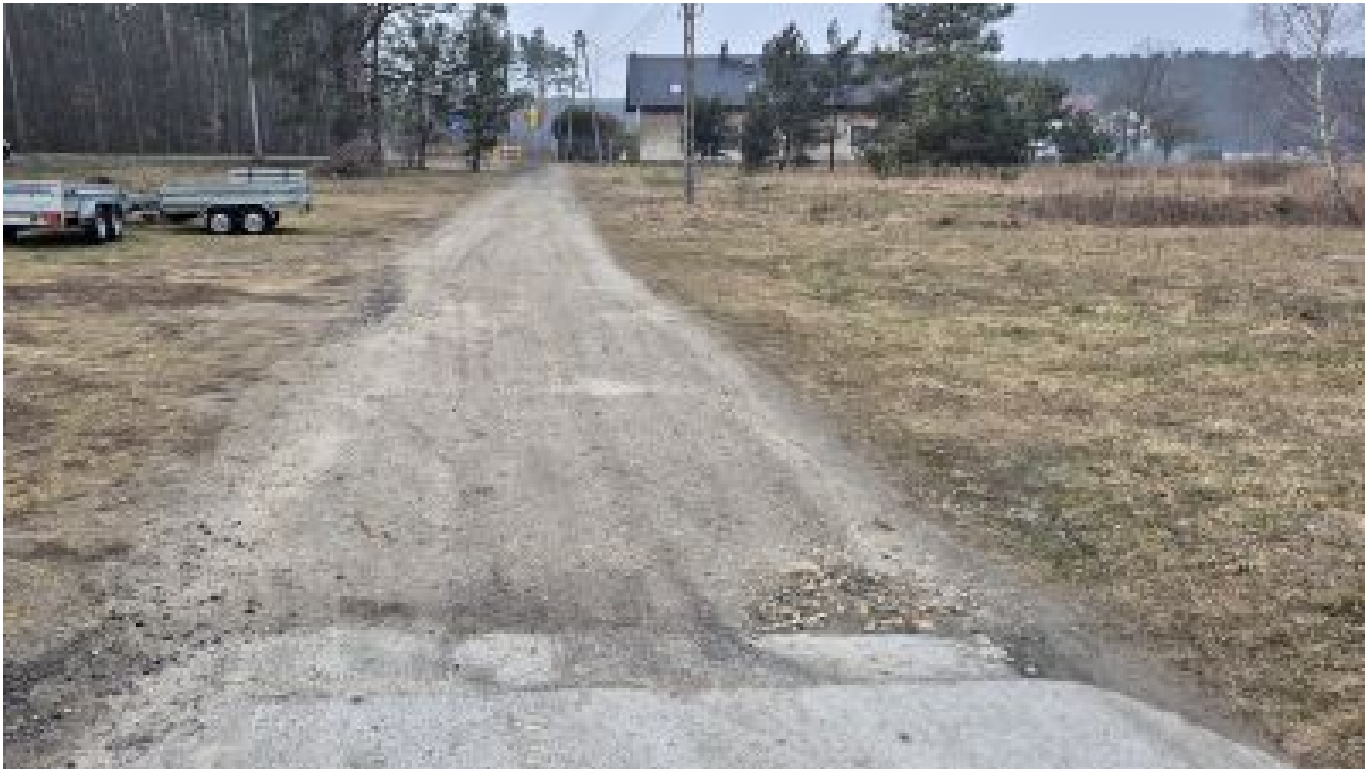
Ulica Opolska w Schodni przed remontem.
