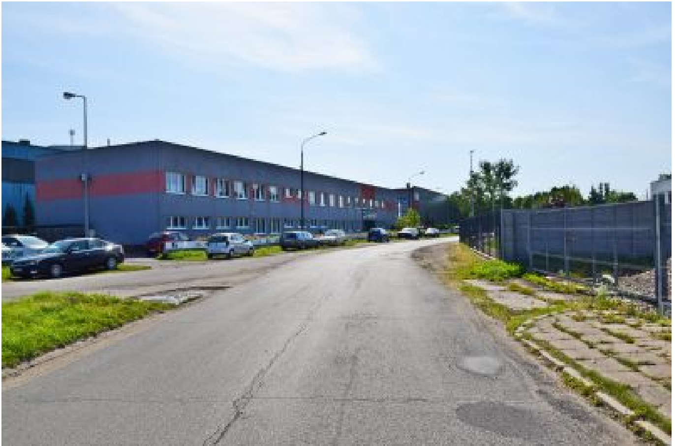
Zostanie wyremontowana druga część ul. Powstańców Śląskich w Schodni (fot. MW)
