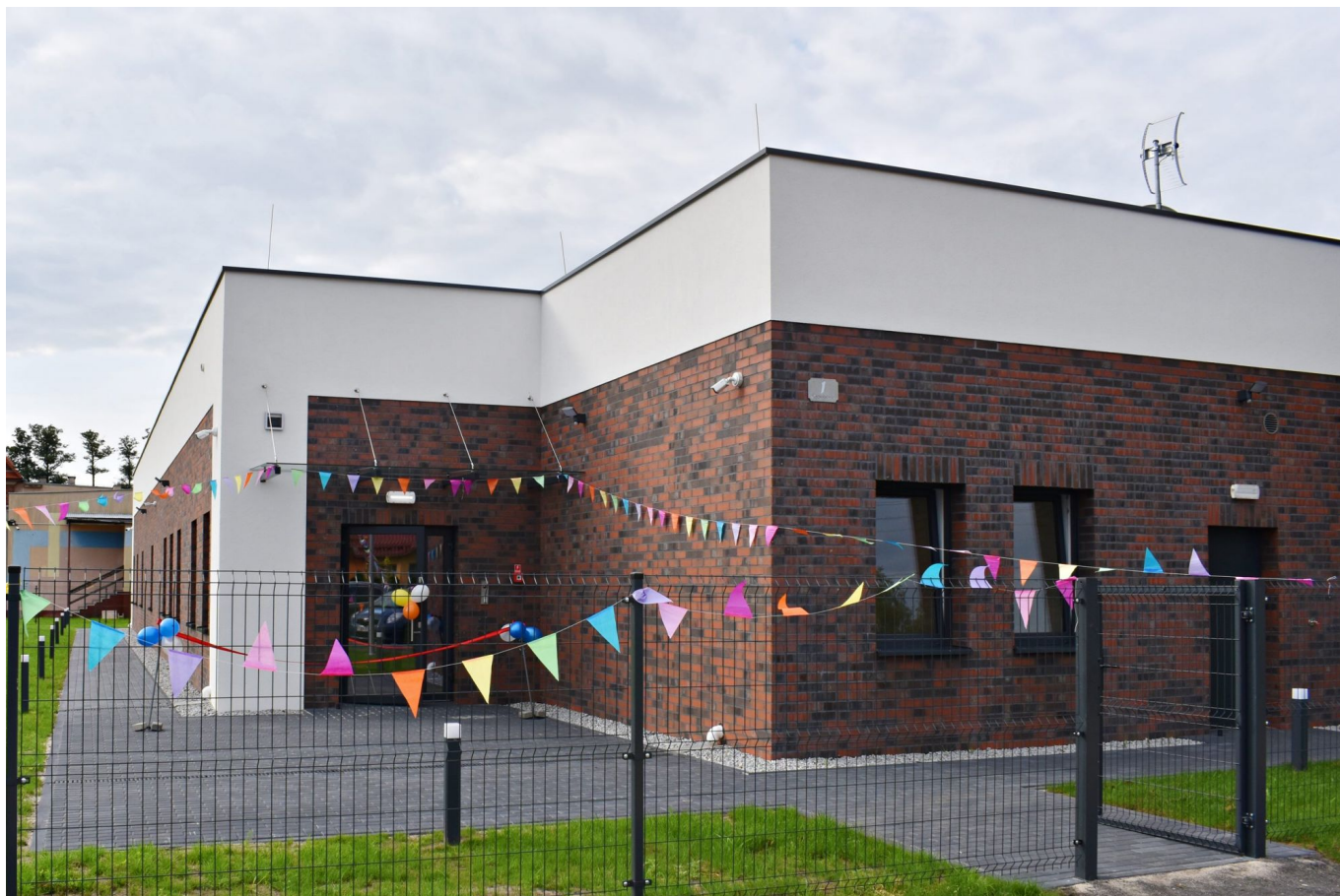
Na zdjęciu nowy budynek przedszkola w Grodźcu
