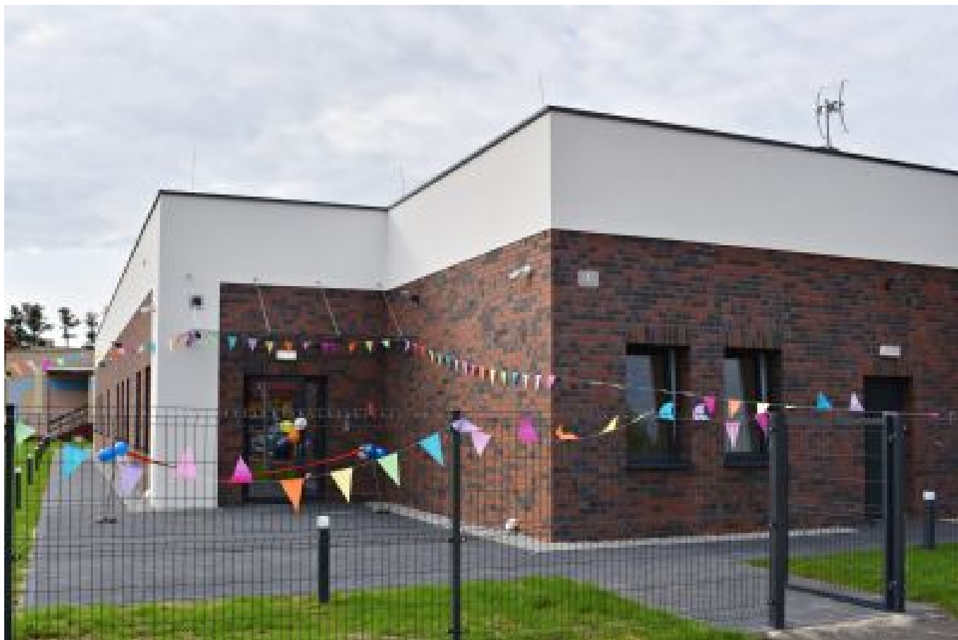
Na zdjęciu nowy budynek przedszkola w Grodźcu
