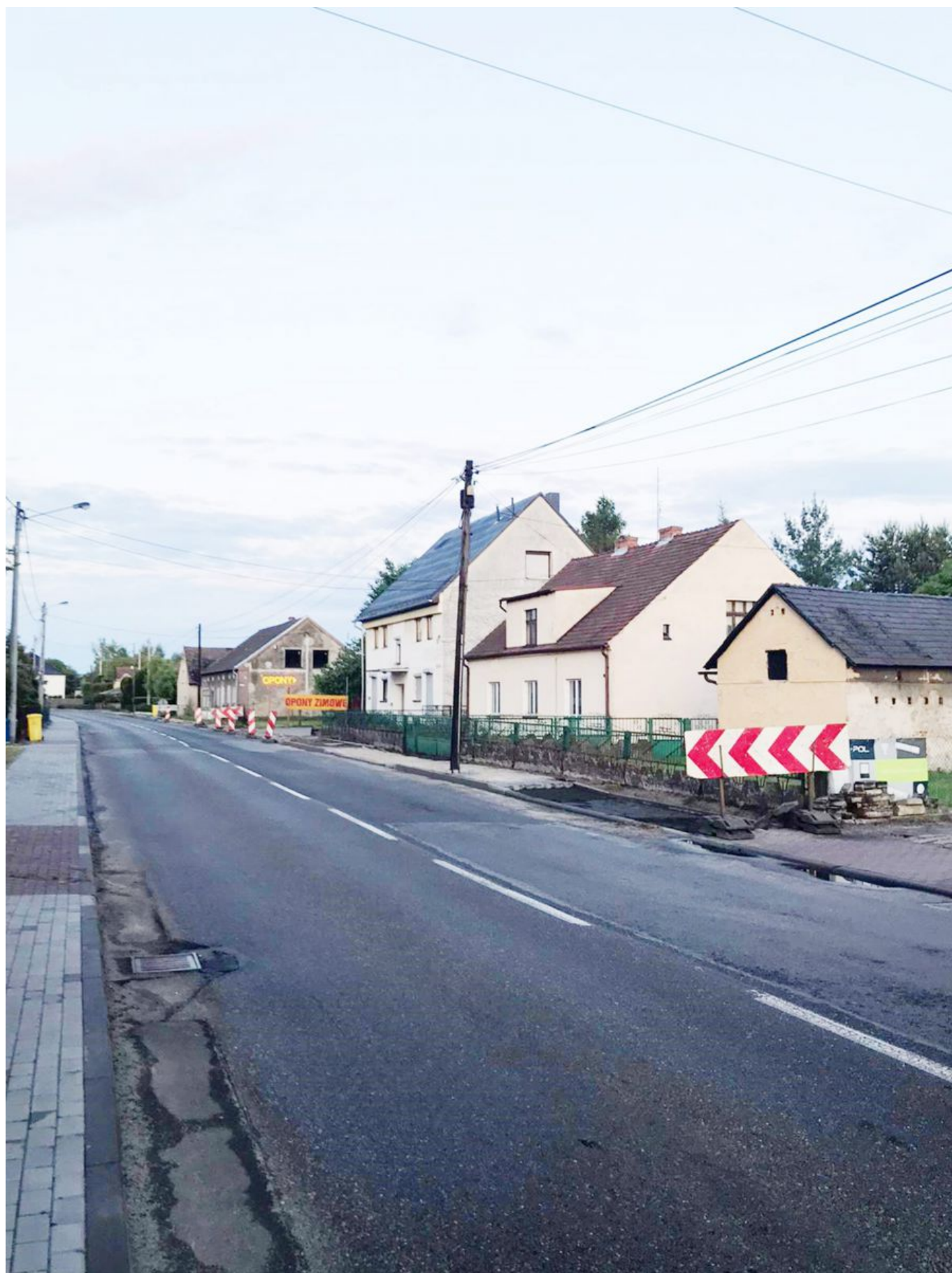
Remont chodnika wzdłuż ul. Wyzwolenia w Ozimku
