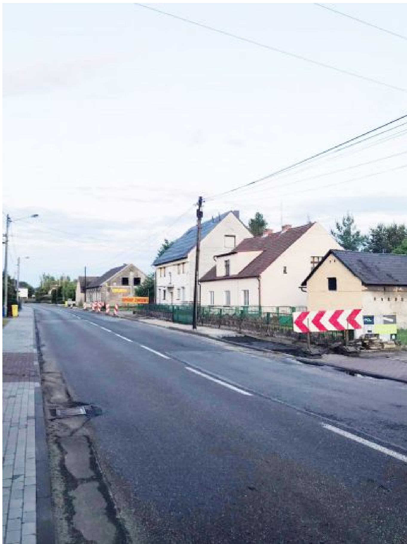
Remont chodnika wzdłuż ul. Wyzwolenia w Ozimku
