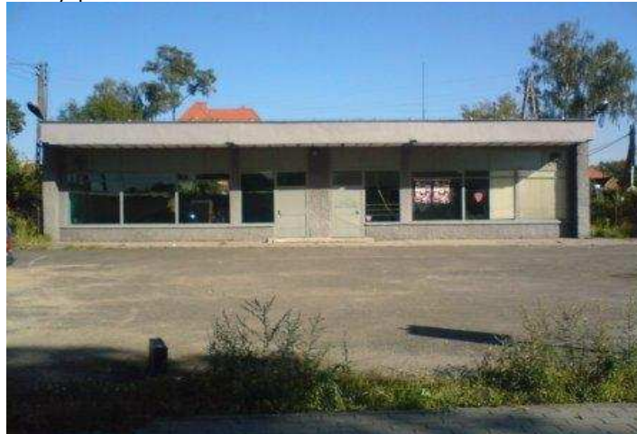
Rys. 1 Pawilon handlowy przed remontem
