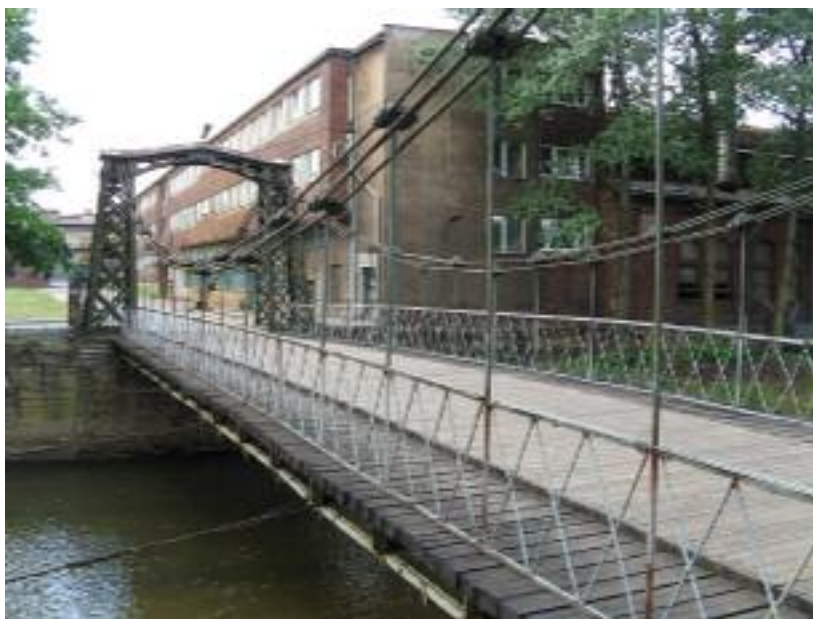
Rys. 2. Widok na most wiszący w Ozimku od strony górnej wody (2008 r.)
