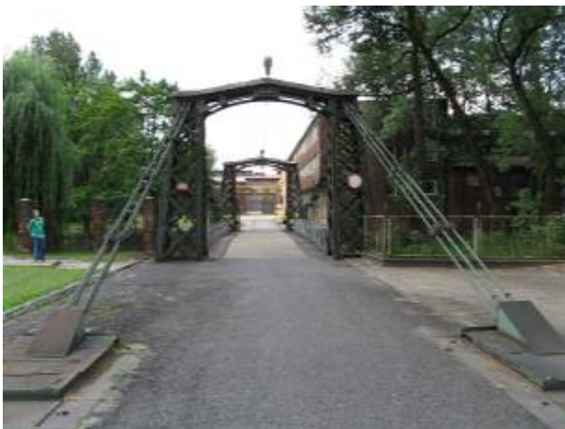
Rys. 5. Widok na wjazd na most od strony centrum miasta
