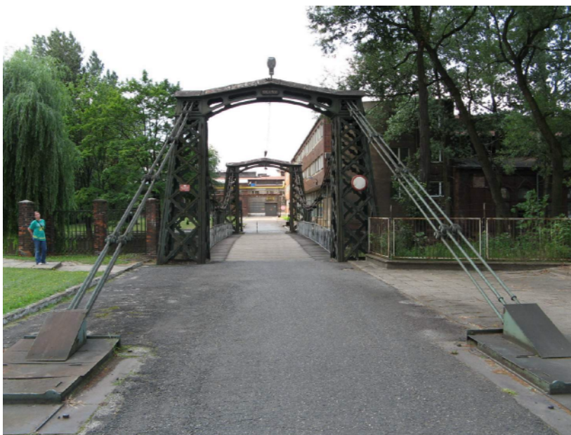
Rys. 5. Widok na wjazd na most od strony centrum miasta
