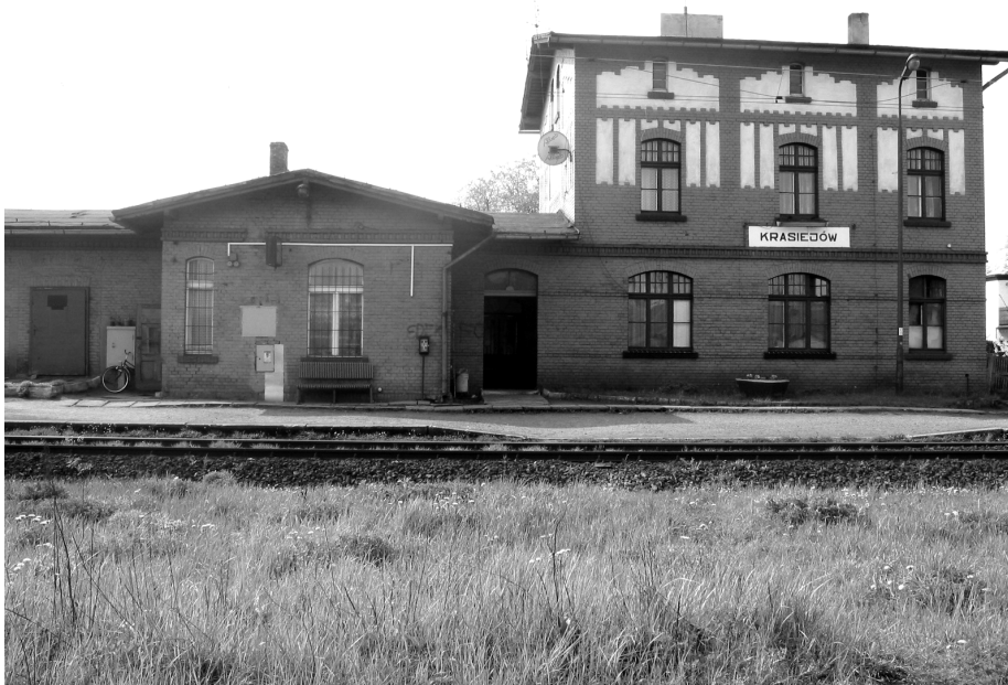
Zdj. 3. Stacja kolejowa- stan obecny.
