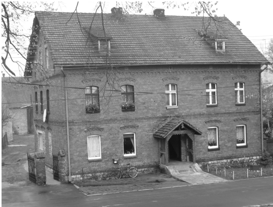
Zdj. 14. Budynek mieszkalny dwukondygnacyjny z poddaszem na ul. Sporackiej 22.
