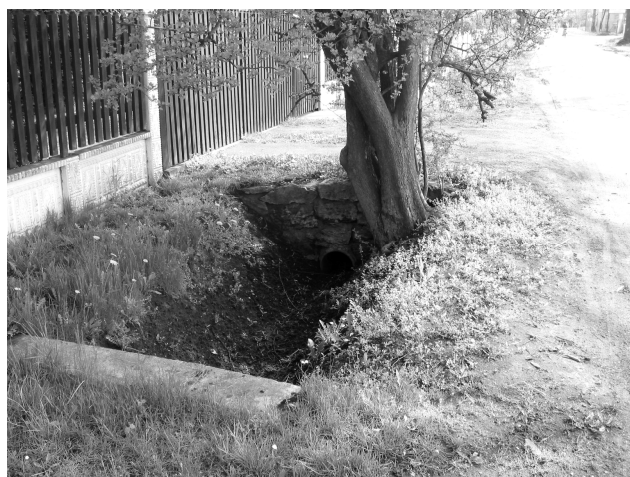
Zdj. 79. Rów melioracyjny przy ul. Cegielnianej nr 29.
